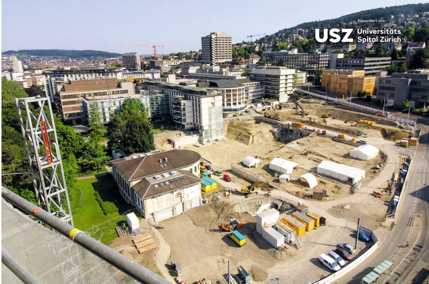
Baustellen-Webcam vom 6. Juni 2023: Die alten Gebäude auf dem Baufeld sind verschwunden.
